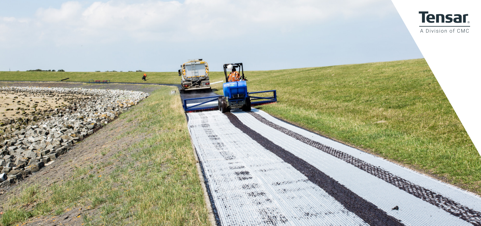
Aanbrengen asfaltwapening
