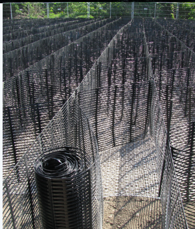
TensorTech® Stratum® bestaande uit vormvaste Tensor® uniaxiale RE-geogrids en de Tensor® InterAx® geogrids
